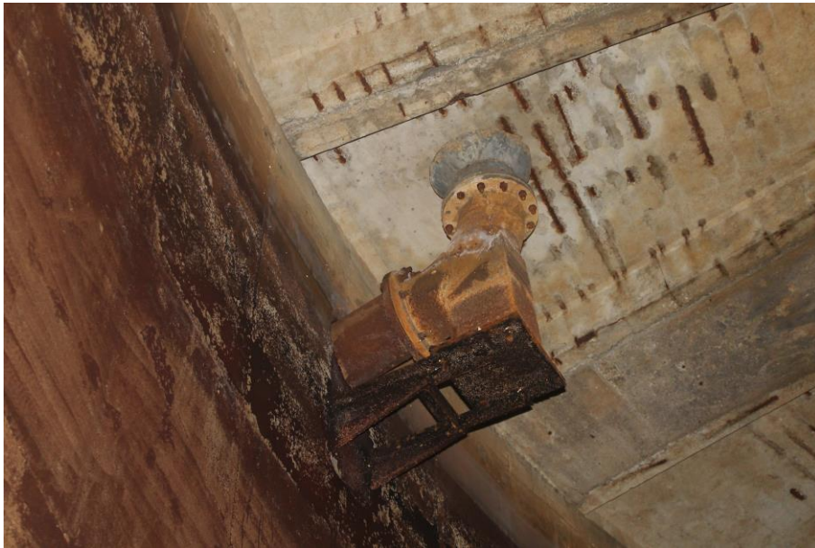
Zdjęcie rurociągu przelewowego
