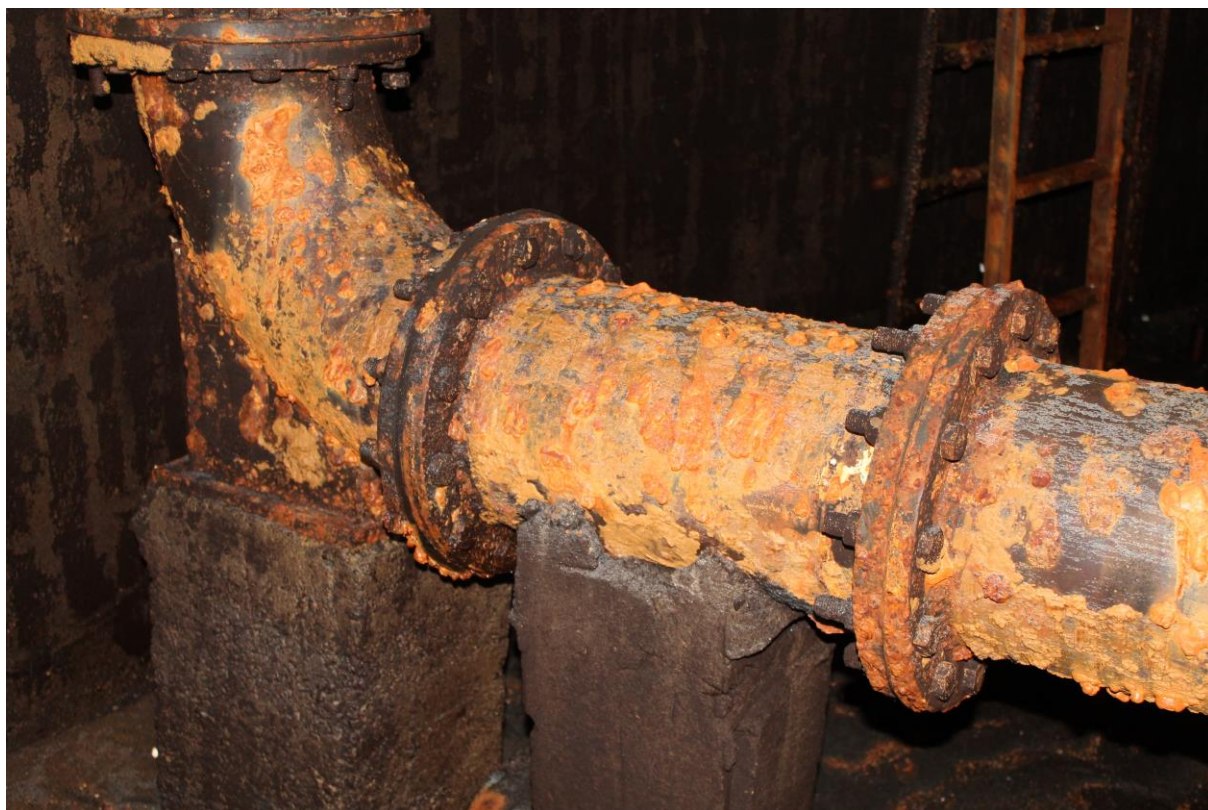
Zdjęcie rurociągu fi 250 zasilającego
