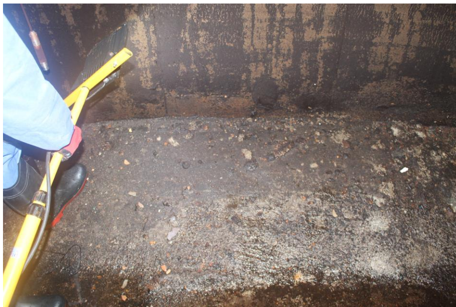
Połączenie ściany z dnem zbiornika
