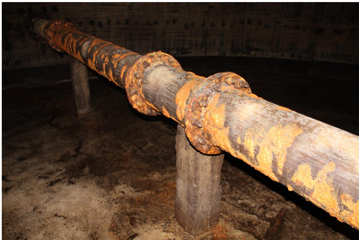
Zdjęcie rurociągu fi 250 zasilającego
